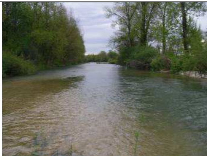
Vue du site avec un débit de 120 m 3 /s (le 29/04/2012)
